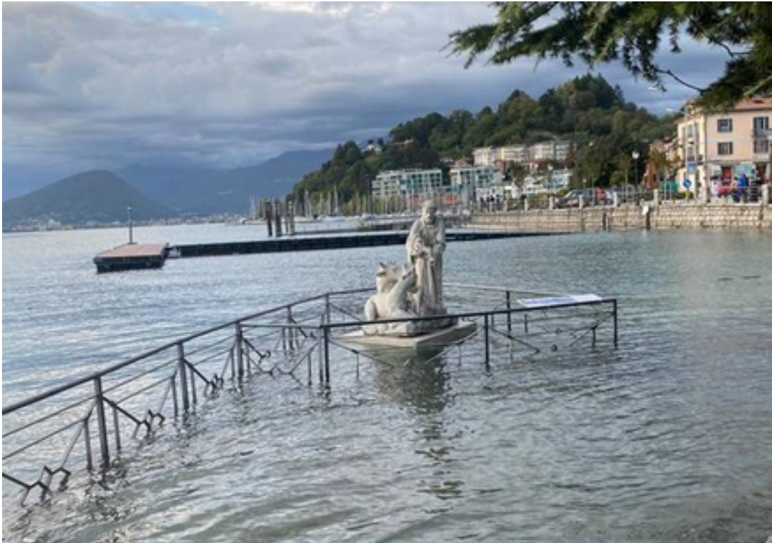
Figura 11: Le forti piogge di sbarramento dei giorni 2-3 ottobre hanno portato all'esonazione del Verbano che ha raggiunto 195.75 m slm il 4 ottobre (foto Varesenews lungolago di Laveno, giorno 4 ottobre).
